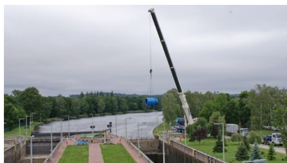
Hier wurden sie von einem 500-t-Autokran in die Schieberkammer eingehoben.
