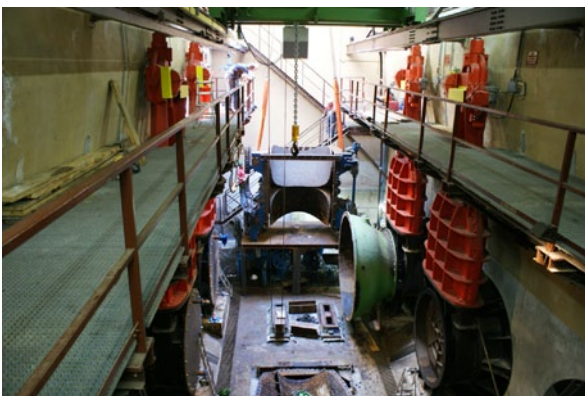
Bereits die Demontage der alten ca. 43 t schweren Ringkolben- und Walzenschieber und das Herausheben aus der Schieberkammer bedeuteten eine technische und logistische Herausforderung.
