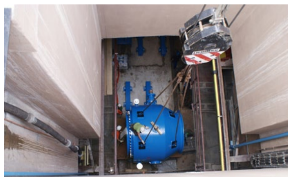
Die Armaturen wurden auf einem extra angefertigten Montagetisch abgesetzt und von hier aus mit dem Brückenkran auf das neu errichtete Betonstreifenfundament gehoben.
