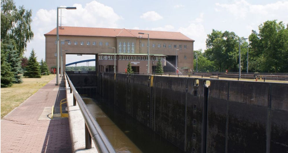
Schleuse Eisenhüttenstadt: Beim sogenannten Doppelschleusenbetrieb – dabei fährt ein Schiff zu Berg, ein Schiff zu Tal – wird der Wasserspiegel in beiden Kammern durch unterirdische Verbindungschanäle ausgeglichen.
