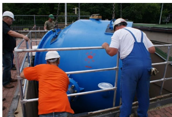
Einheben eines Walzenschiebers in die Schieberkammer.
